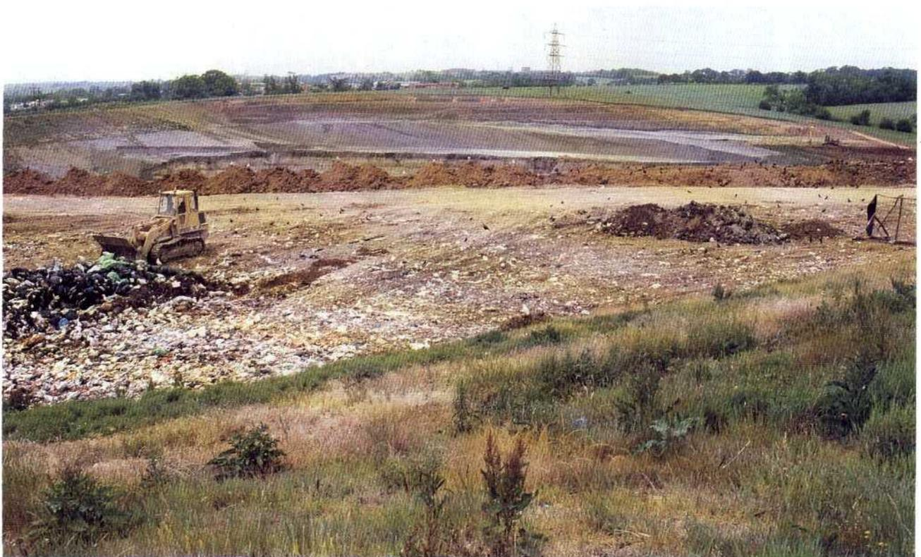
*Una posibilidad que ofrecen las graveras en las que no se llega a explotar por debajo del freático, es la utilización del hueco como vertedero controlado. En la gravera de la fotografía, las operaciones de extracción del material, sellado del fondo del hueco, vertido de los residuos y clausura y restauración del vertedero se van realizando de forma progresiva y simultánea, utilizándose la capa de arcillas grises que aparece situada por encima del material aluvial.*
