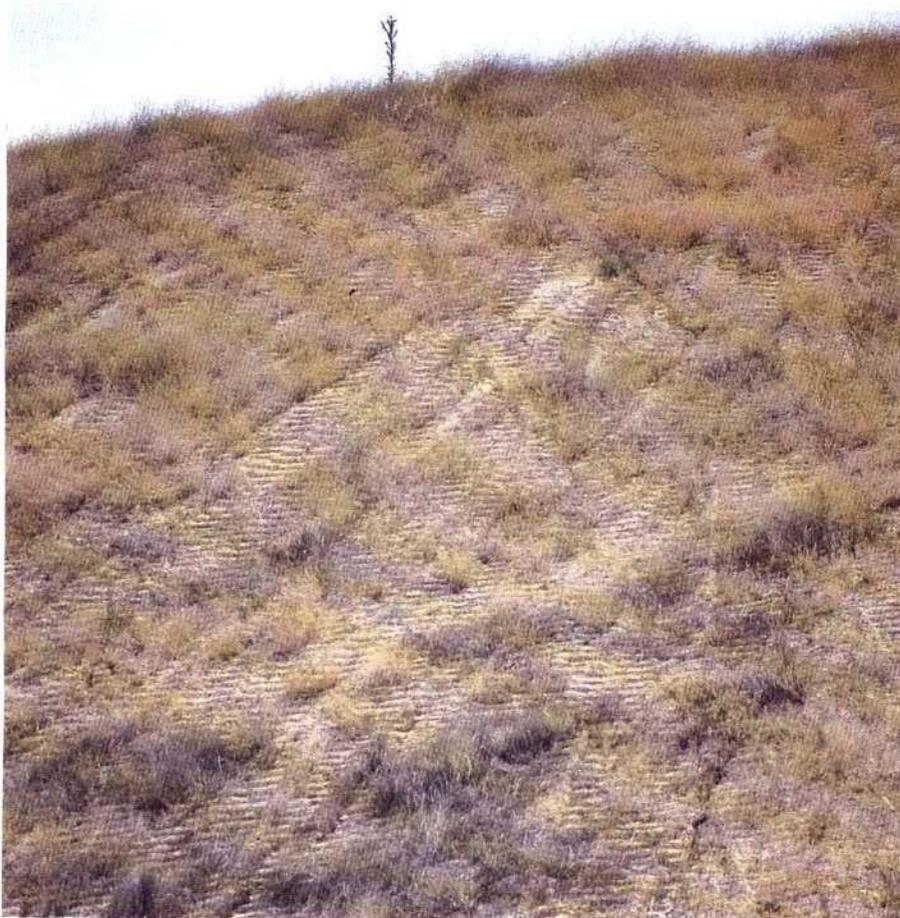
*Siembra fallida de la pared de un hueco debido a que, durante las operaciones de remodelado y preparación del sustrato, la maquinaria ocasionó una compactación excesiva del suelo. Se pueden apreciar incluso huellas de cadenas dejadas por las palas con las que se realizaron las labores.*
