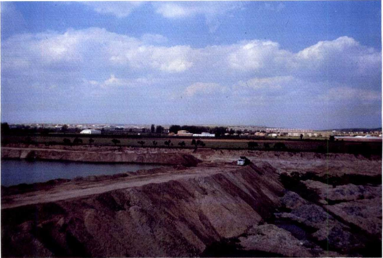
*Aprovechamiento del hueco de una gravera para su relleno con materiales inertes procedentes de excavación de solares y escombros de derribo de edificios.*
